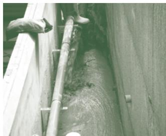
流動化処理土(高流動埋め戻し材)の打設状況
