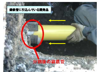
既設管より大口径の開発品を 割りながら引き込み設置可能
