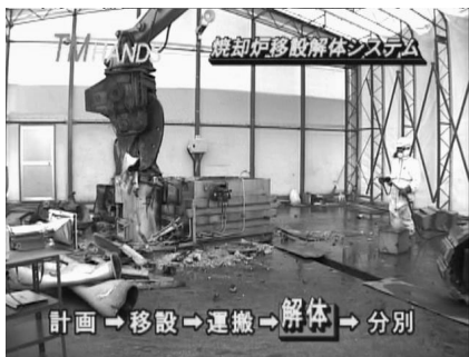
重機による解体作業
